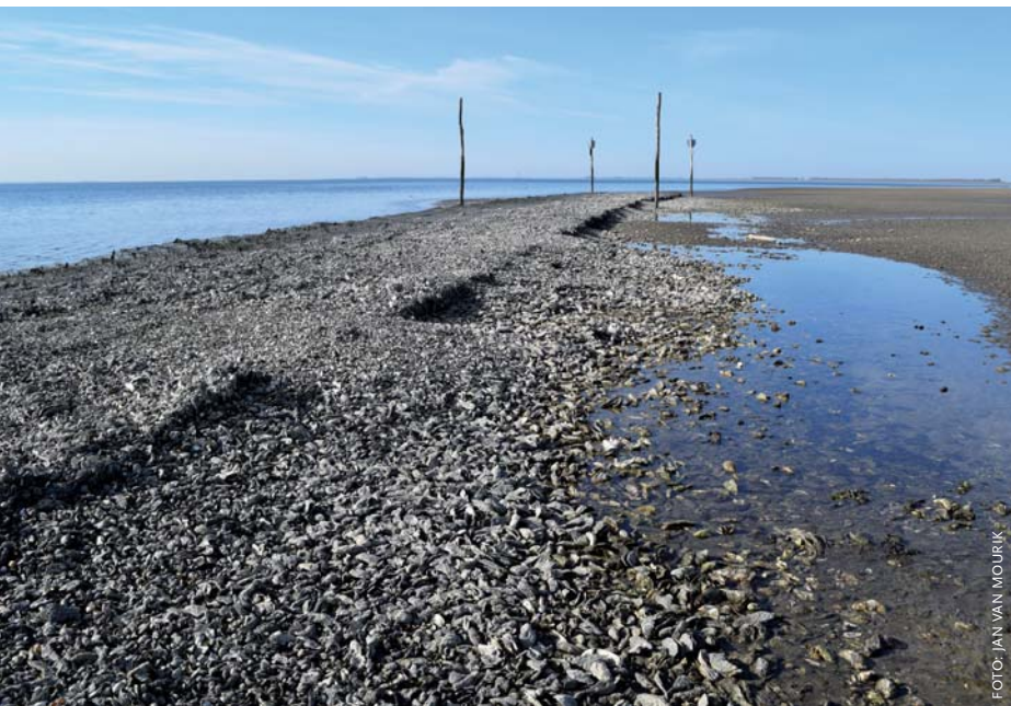
Bouw van een oesterbank in het oostelijk Oosterscheldebekken om verdere erosie van zandbanken te bestrijden.
